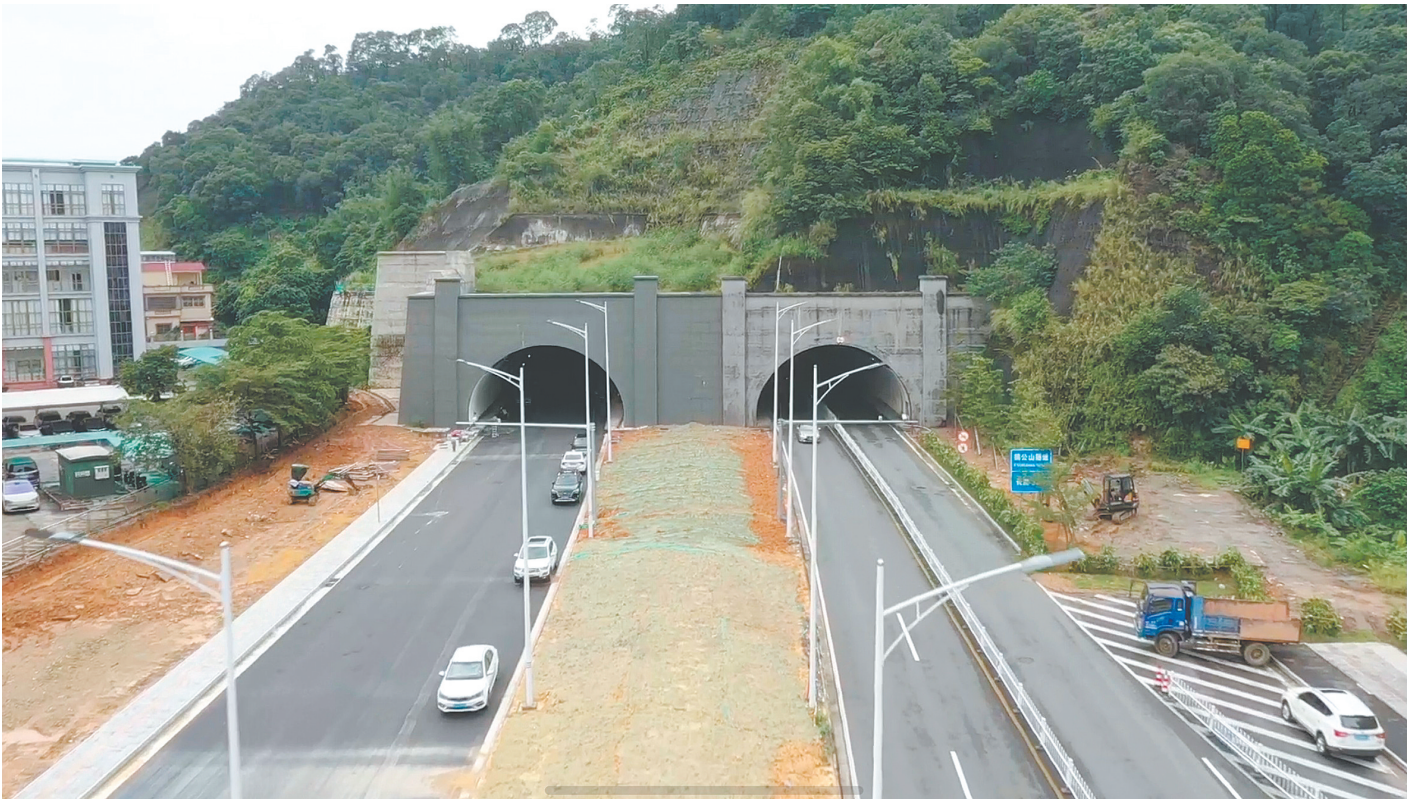
鹅公山隧道左洞主体工程基本完工，后续作业正在陆续推进。
