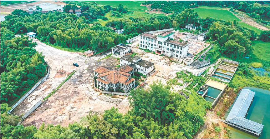
修缮中的台山泡步村立德学校。
