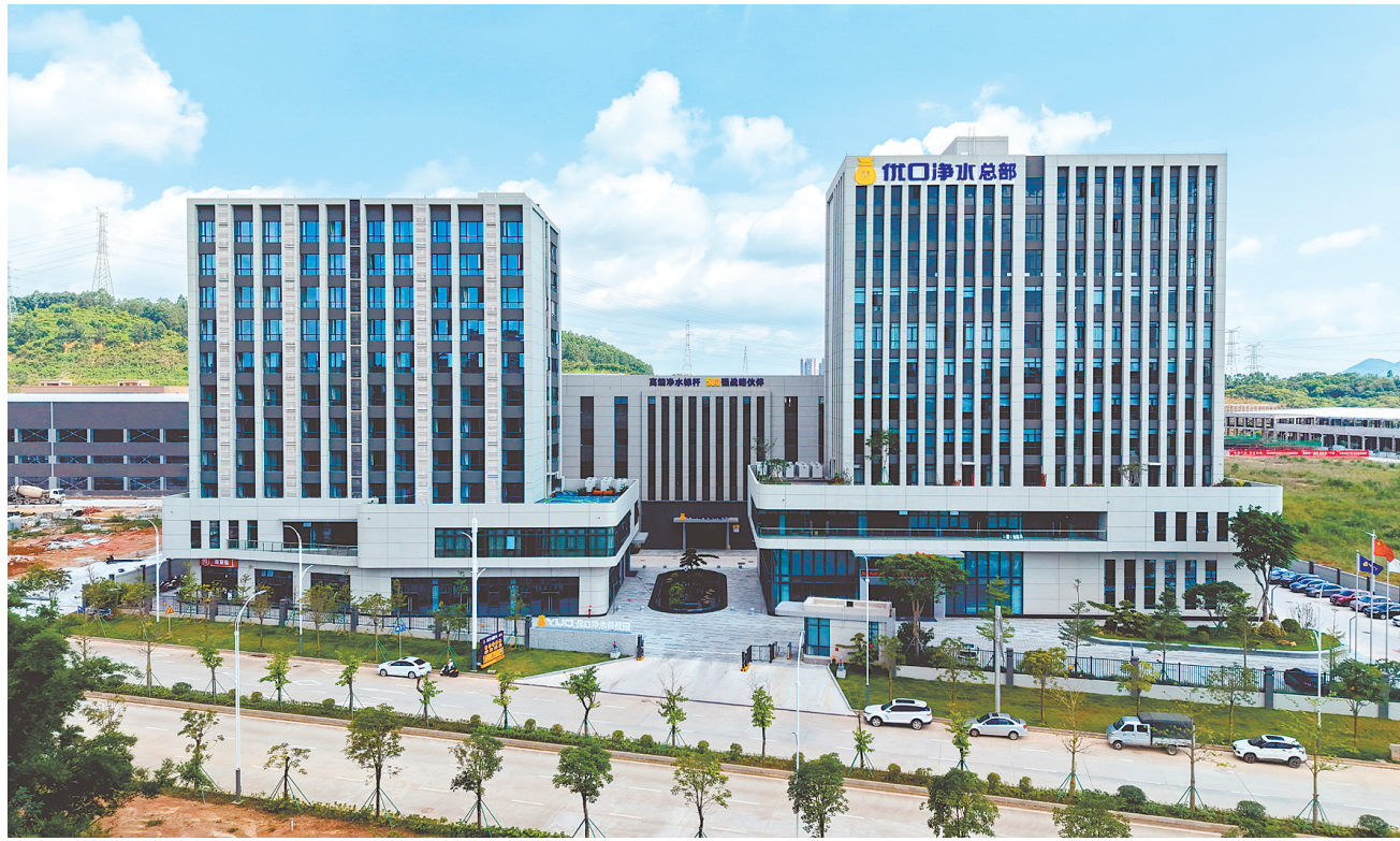
优口净水科技园从奠基到试生产仅用18个月。
