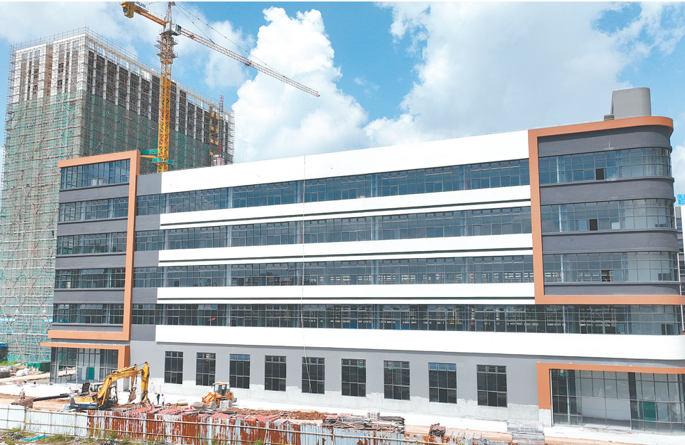
汇鼎储能的厂房已建成，首批生产设备将进场调试。
