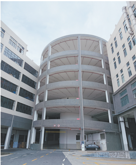
在奇德新材，货车能够通过环绕车道开上楼。
