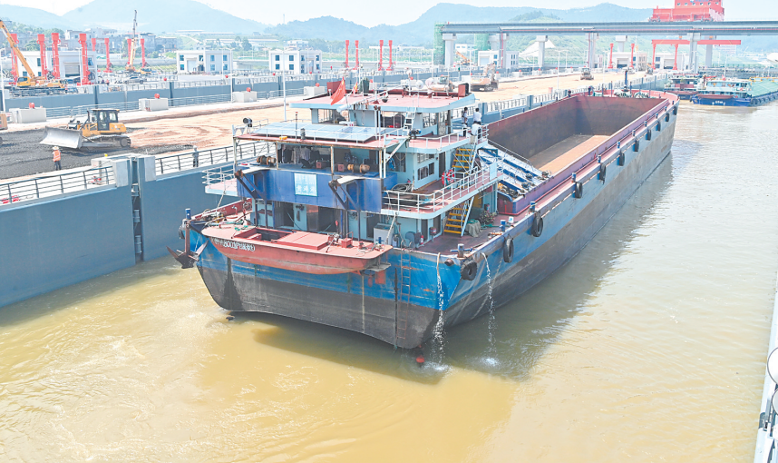
8月12日，试验船舶驶进平陆运河马道枢纽船闸。新华社发
