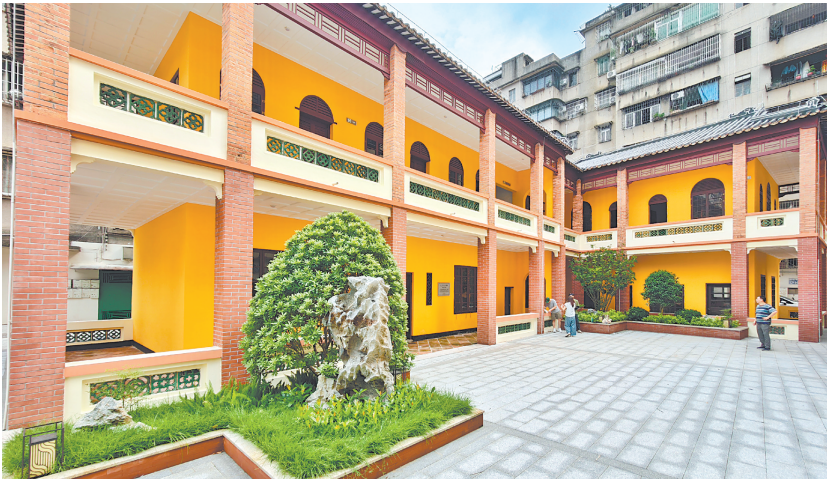
修缮后的新会杨西岩旧居。郭永乐 摄
