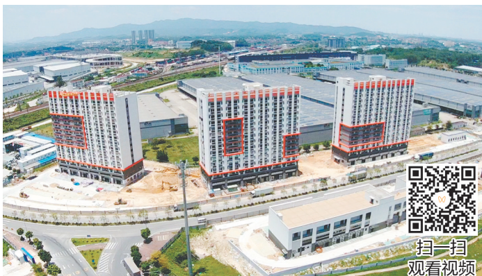
桃源河畔生活配套项目已全面进入室内装修、室外工程收尾阶段，即将迎来竣工验收。
