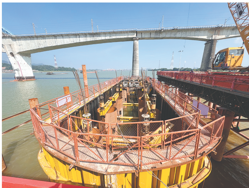
在智能系统控制下,500吨“钢铁巨笼”在西江中缓缓下沉。
