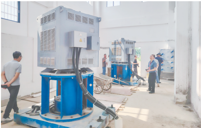
开平市人大常委会组建专项调研组，对开平全市防洪排涝工程体系开展一次全面“体检”。
