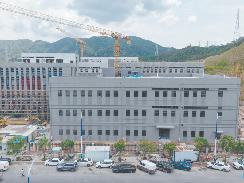
德众泰新材料有限公司所有单体建筑已封顶。
