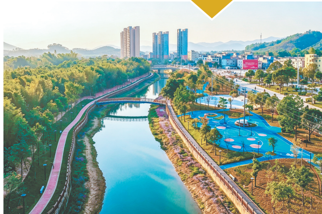
改造后的良西镇三山河美丽河道。
