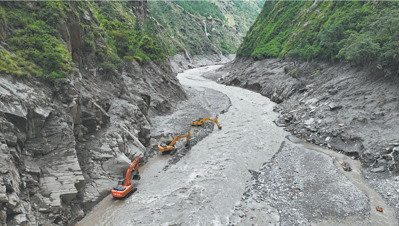
8月29日,救援力量持续对G216国道损毁路段全力开展抢通作业(无人机照片)。
