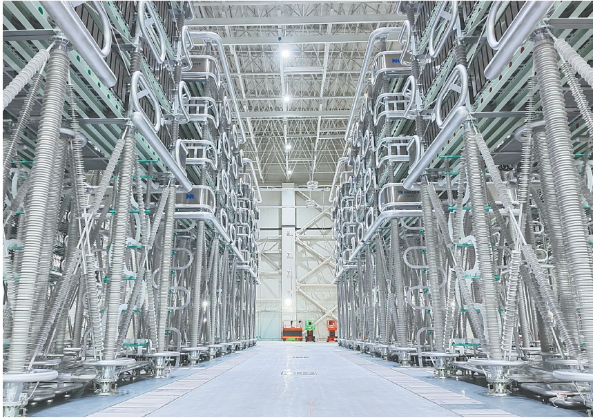
±500千伏古澜换流站柔直换流阀阀塔试验于日前全部通过。
