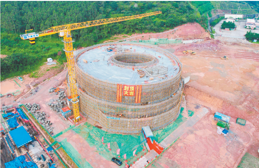
昨日，广中江高速棠下服务区南区服务楼主体结构封顶。
