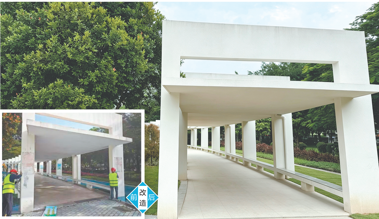
棠下镇推进陈垣文化广场及周边人居环境提升工程，让老旧广场实现颜值与功能双提升。图为陈垣文化广场文化长廊。
