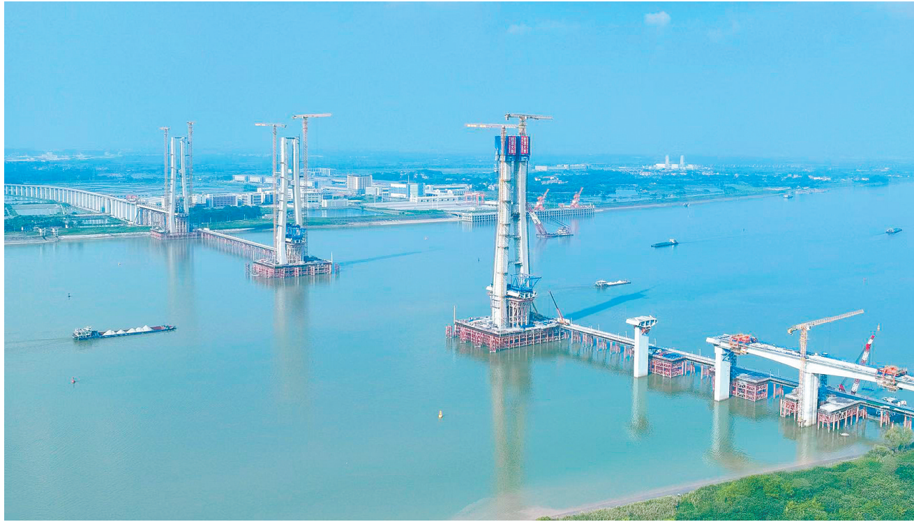
9月21日,珠肇高铁西江特大桥76号主塔完成塔冠最后一斗混凝土精准浇筑。
