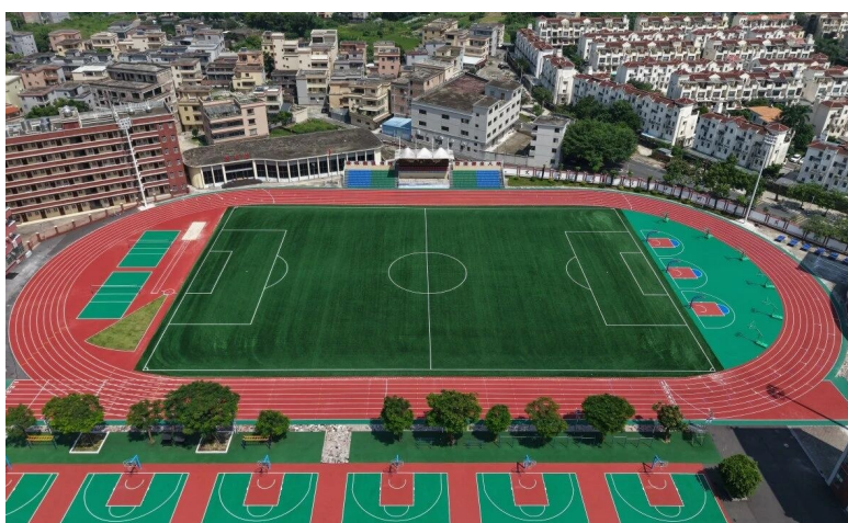
恩平黄冈实验中学运动场完成翻新改造。
