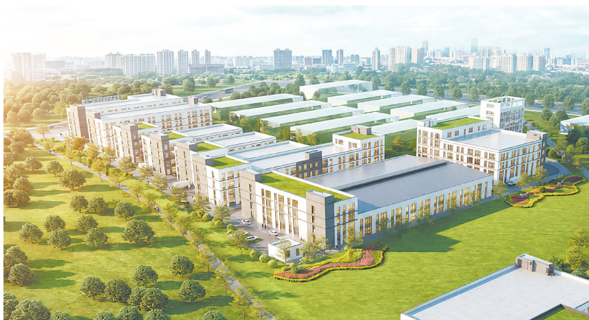
澳湾新连科技产业园从拿地到开工,仅用19天。图为澳湾新连科技产业园效果图。
