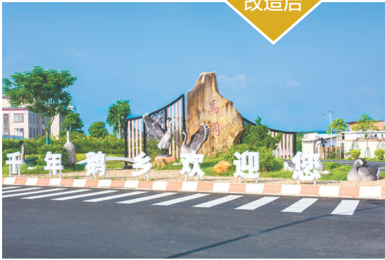
改造后的马冈入口通道。
