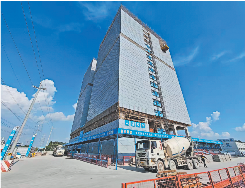
鹤山升仕项目施工现场，施工单位抢抓国庆假期的黄金时间加紧推进建设进度。
