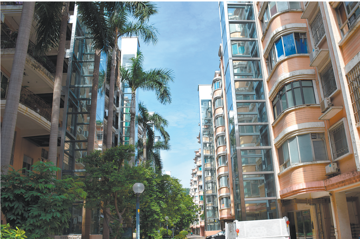
在怡兴苑小区,多台钢架结构电梯紧靠楼宇,外形美观。
