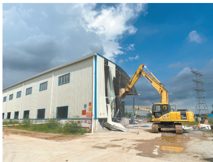
荷塘镇拆除违法建筑。
