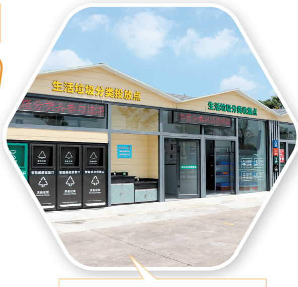
蓬江区多个村(社区)已经新建了农村生活垃圾分类投放点。
