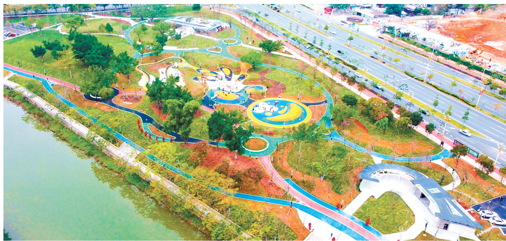
目前,天沙河碧道棠庄公园景观工程已竣工启用。区人大办供图
