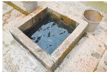
立村之时开挖的古井常年满水，井边有小孔防水溢满，古井水清如甘露滋润了世代村民的心田。
