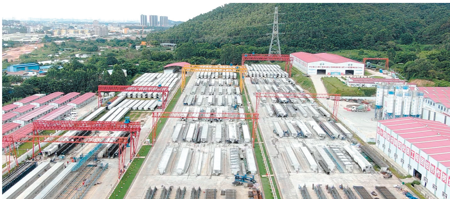
预制梁场采用自行式整体液压模板等一系列新工艺,实现了高效率、标准化、智能化生产。
