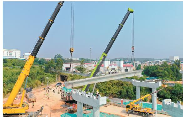
江门日报讯(文/图 毕松杰 郭永乐 周洪旭)9月16日,在江鹤高速共和枢纽立交H匝道桥梁架施工现场,随着一榀长25米、重达74.1吨的预制箱梁稳稳落在共和枢纽立交H匝道桥第11#—12#桥墩上(见上图),由中铁大桥局承建的江鹤高速改扩建项目TJ03标段成功架设全线首榀预制箱梁,为全线桥梁架设按下“加速键”。
