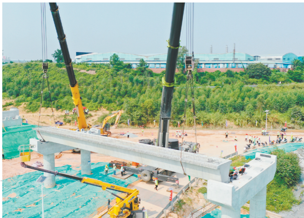
▶9月16日早上,江鹤高速公路改扩建工程项目首片梁成功架设。郭永乐 摄
