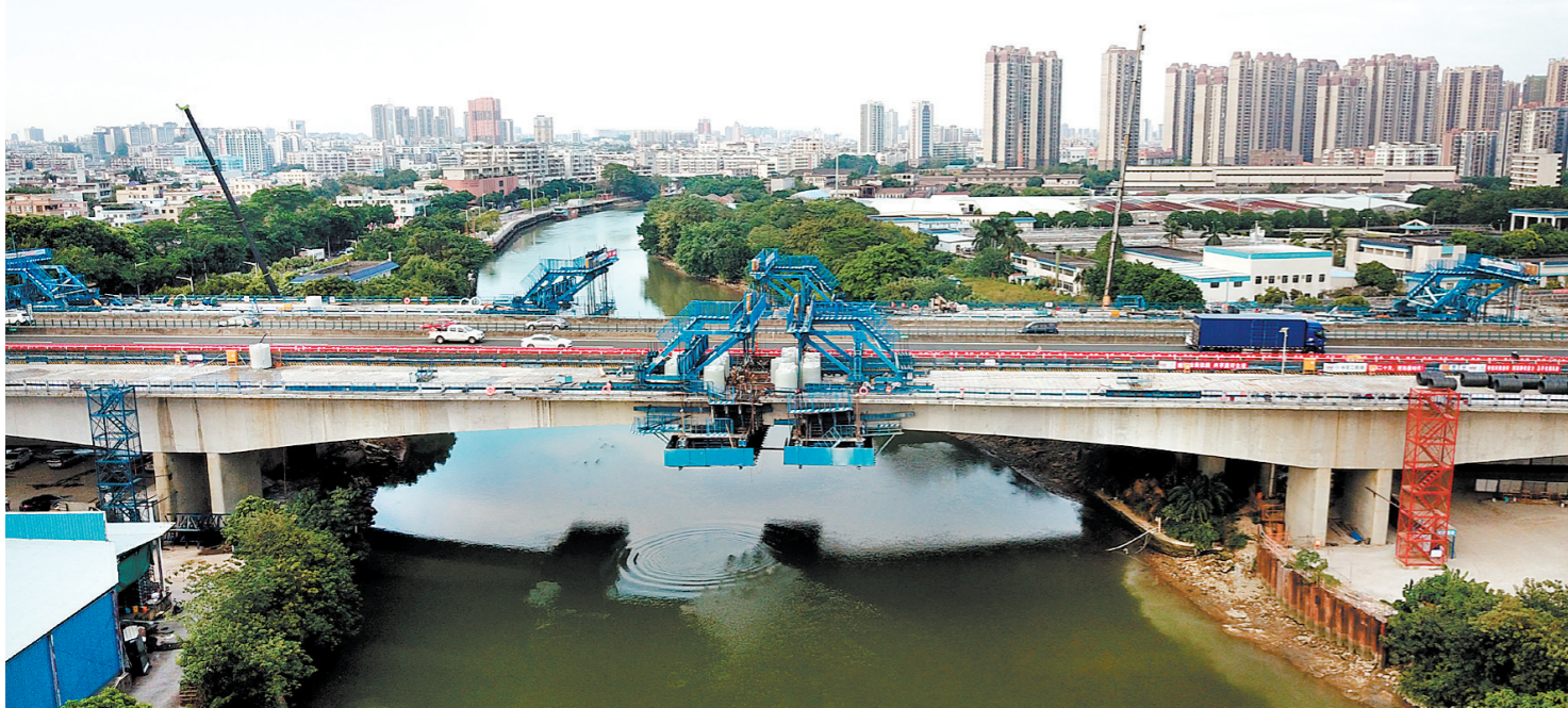
10月23日,中江高速改扩建控制性工程江门大桥主桥左幅成功合龙。
