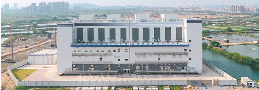
南方电网广东江门供电局220千伏岱建变电站工程已顺利投运。
