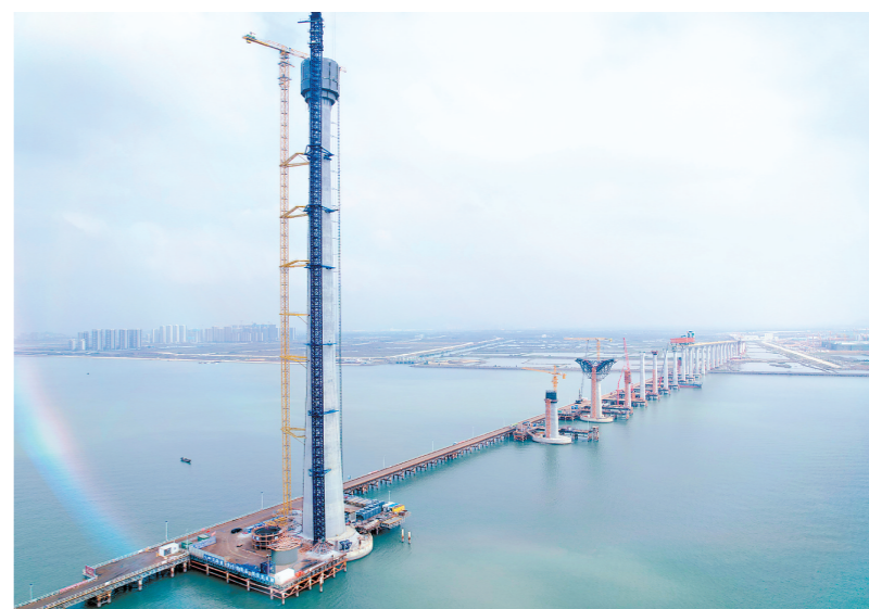
高栏港大桥Z3主塔有望在春节前实现封顶。
