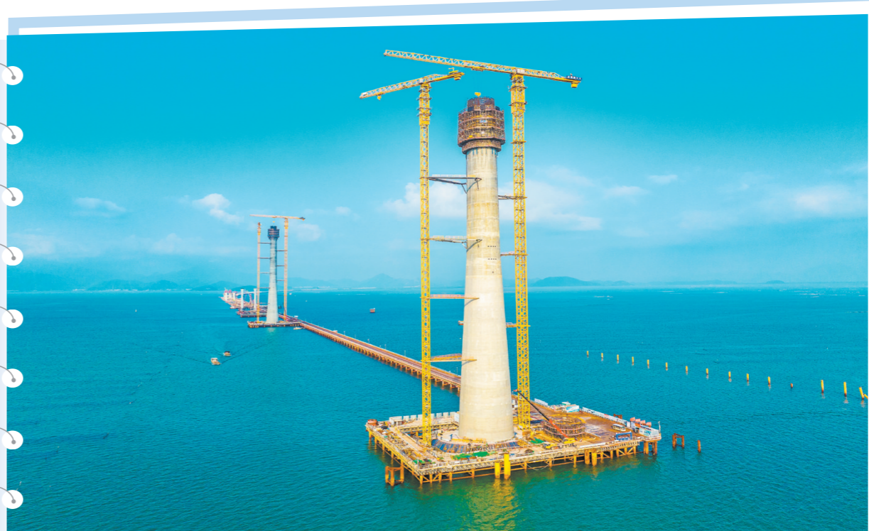
黄茅海大桥主塔塔节攀高,造型如广州经典建筑“小蛮腰”。大桥将成为大湾区新地标。
