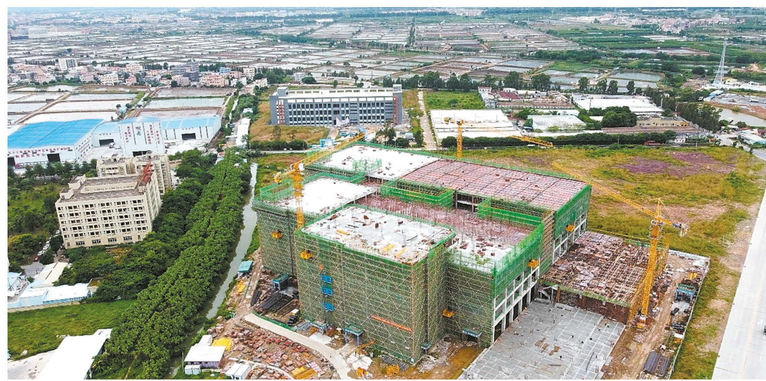
江海区以重大项目落地为抓手,点燃高质量发展引擎。图为优巨新材项目建设现场。
