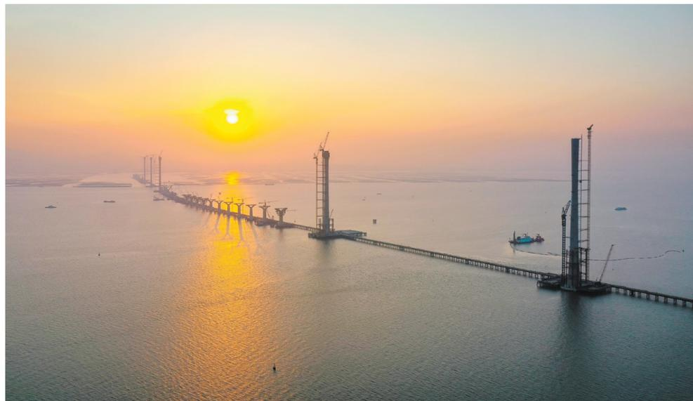
中交路桥承建的黄茅海跨海通道高栏港大桥东主塔(右一)已经封顶,西主塔和黄茅海大桥三座主塔也临近封顶(无人机照片,3月10日摄)。 新华社发
