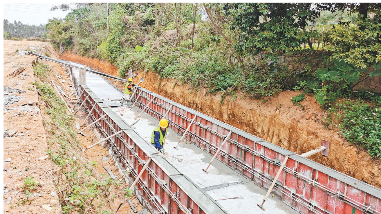
台山市大力推进灌区续建配套与节水改造工程建设，提高水渠利用系数，节省水资源，为粮食安全生产提供坚实保障。
