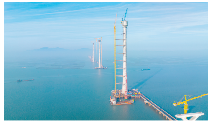
黄茅海跨海通道项目主塔以“定海通天”之势屹立在黄茅海海域上。
