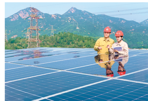
运维队伍每天定期巡检,确保第一时间发现并消除故障。
