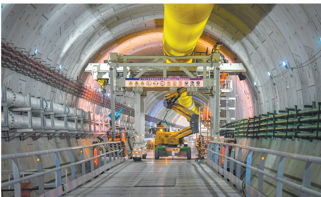
在深江铁路珠江口隧道东莞虎门段,中铁十四局施工人员在检查已拼装管片(4月7日摄)。
