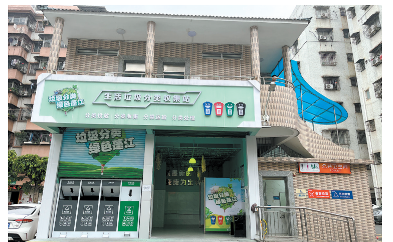
东风生活垃圾分类收集站升级改造后整体风格以绿色为主,室内设置了除臭机、灭蝇灯等设施。
