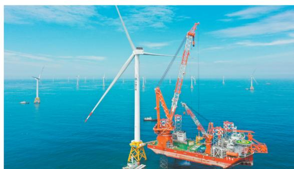
6月28日拍摄的全球首台16兆瓦海上风电机组吊装现场(无人机照片)。记者从中国三峡集团获悉,全球首台16兆瓦海上风电机组6月28日
