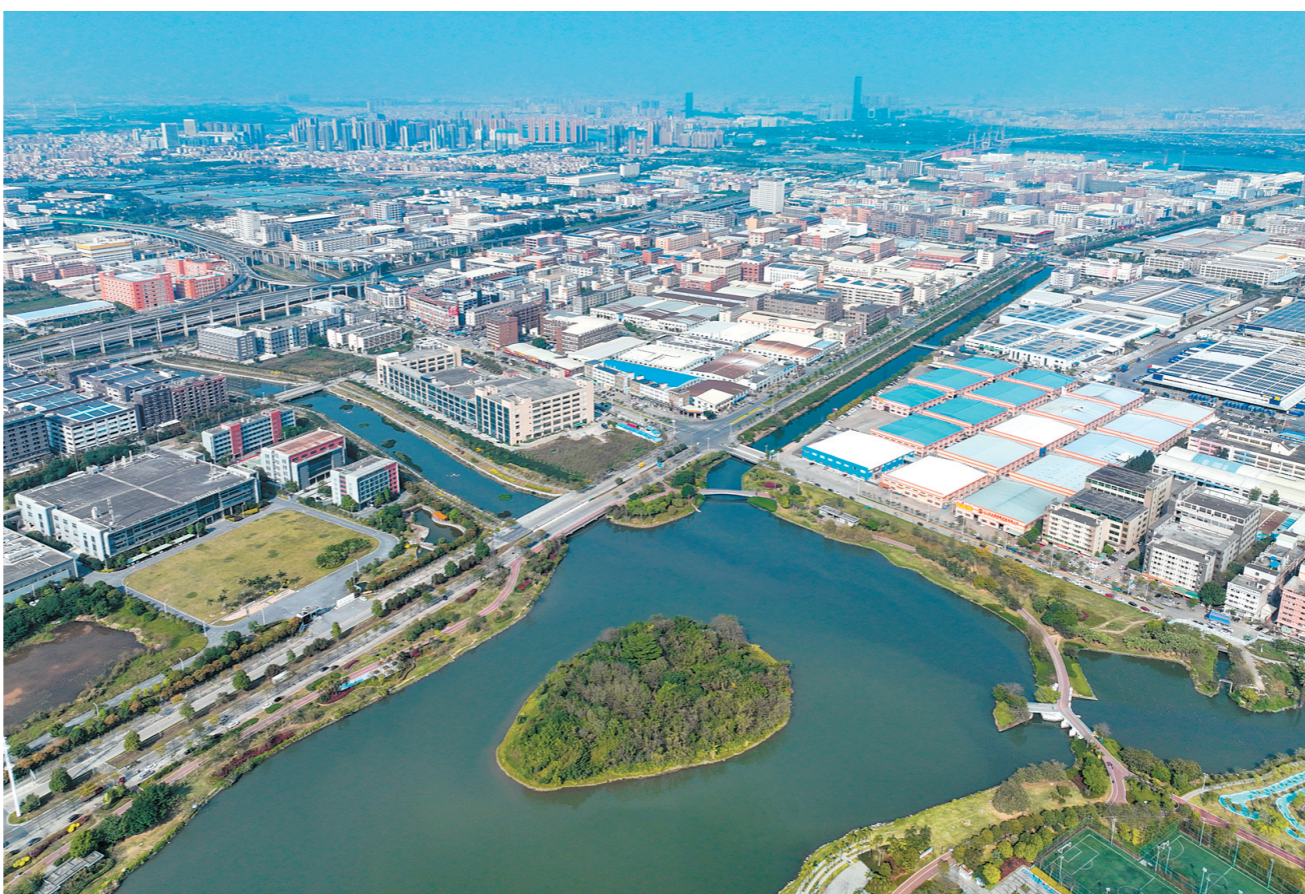
江海区强化“链长制”工作机制,持续稳链延链补链强链控链,加快建设千亿产值园区。图为江海区连片的工业园区。邱昱 摄
