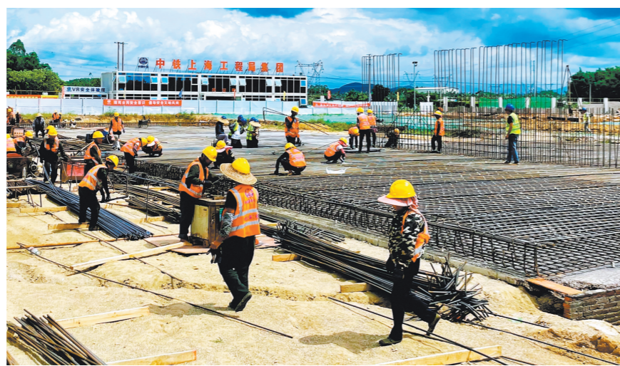
建设者齐心协力,努力将恩平市镇海湾区供水工程建好。
