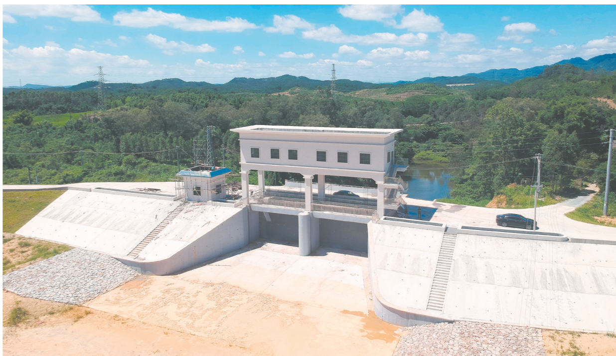
开平市大沙河水库非常溢洪道修建得更加牢固。
