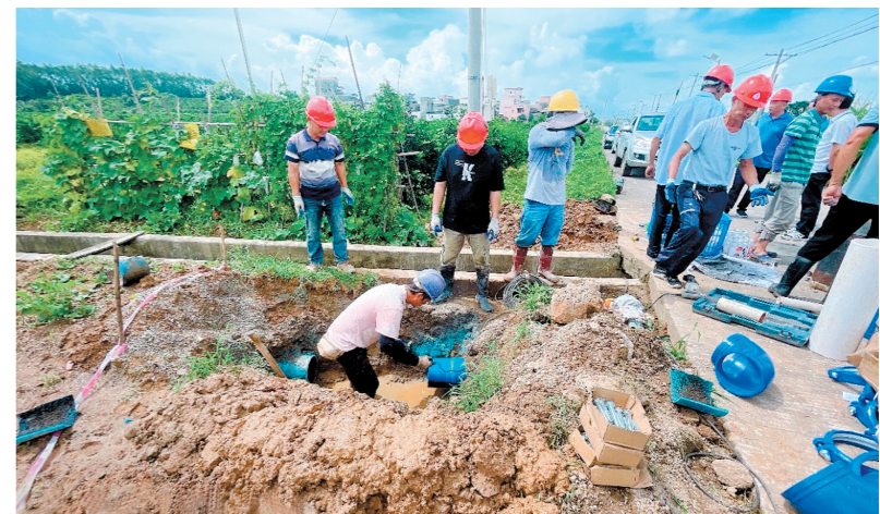
供水主管并网工程让村民喝上“放心水”。
