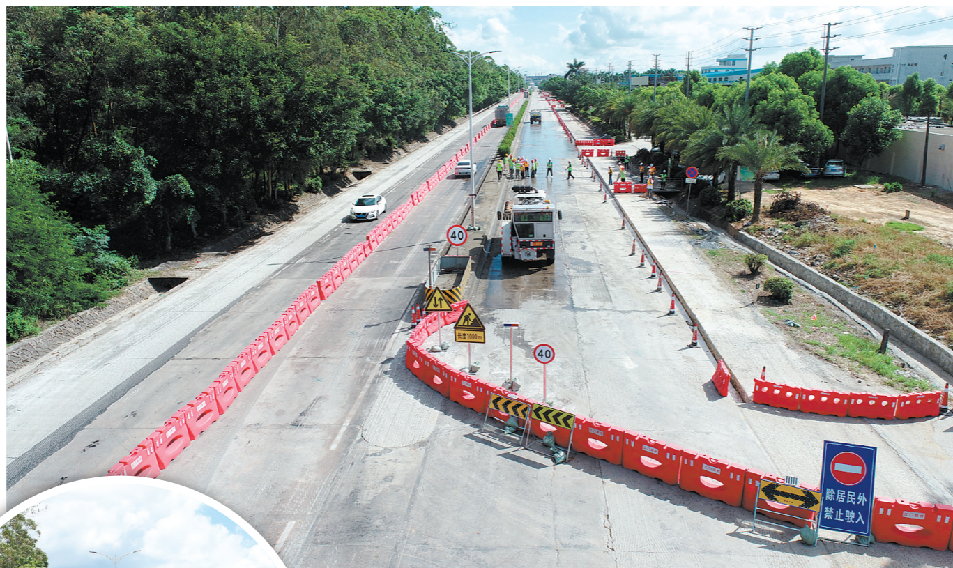
国道G325线恩平圣堂至大槐段路面工程全面开工。
