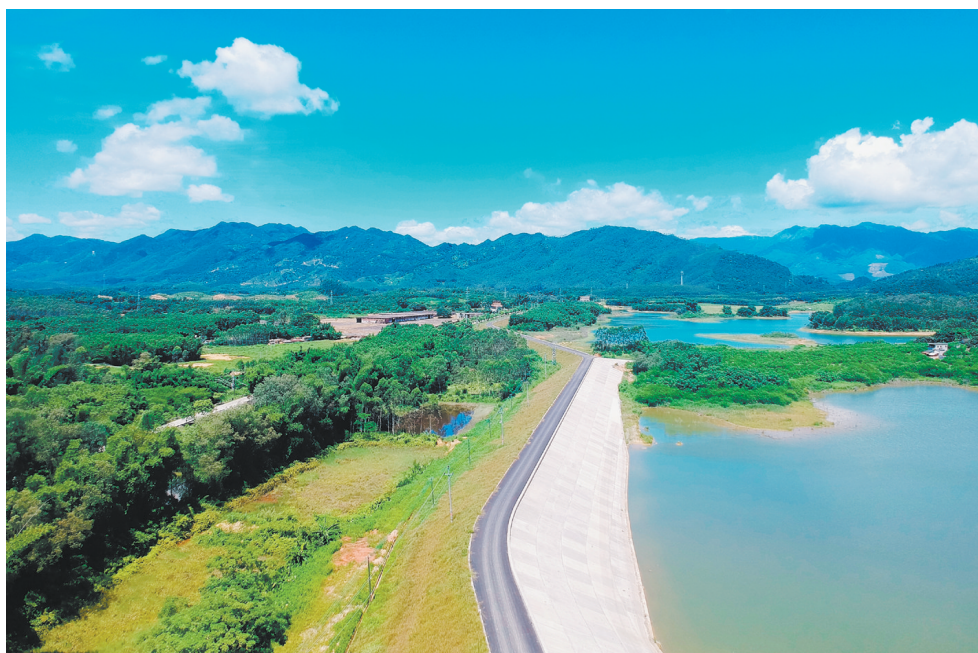
我市水库(水闸)除险加固工程跑出“加速度”,图为加固后的大沙河水库长堤副坝。
