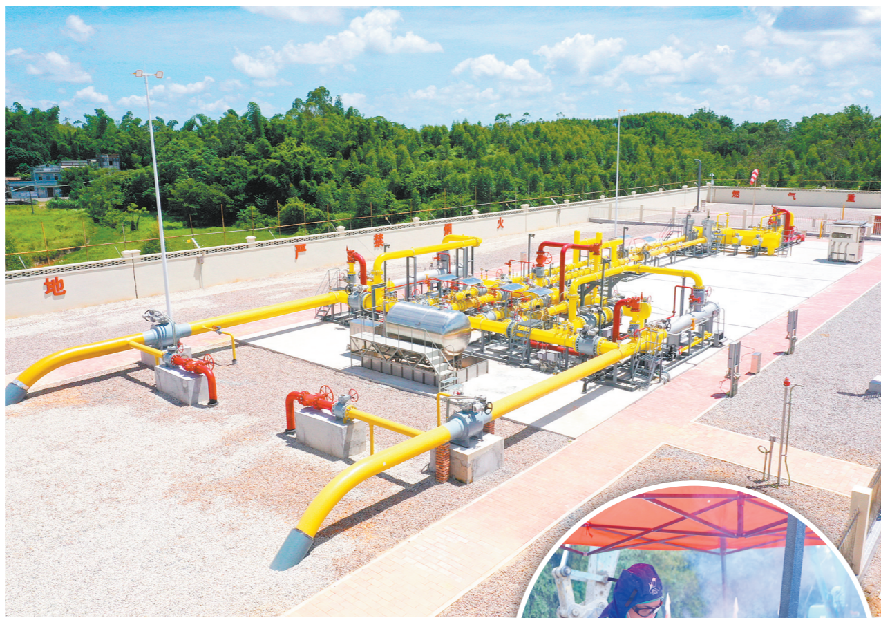
建成通气后的赤坎门站。
