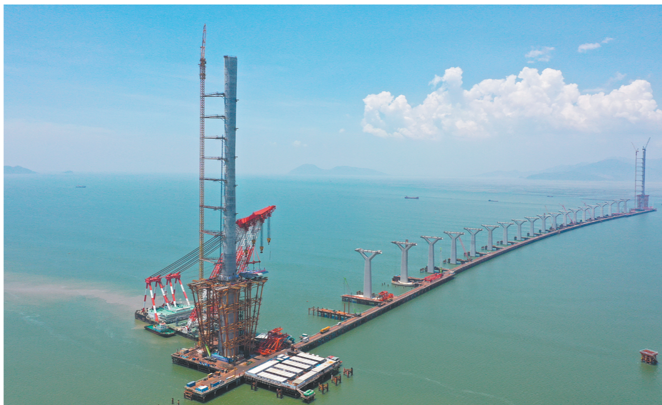
黄茅海跨海通道项目高栏港大桥开启架梁作业，桥面采用分离式钢箱梁结构，能增强桥面的抗风性能，同时大大提高成桥后行车的舒适性与安全性。
