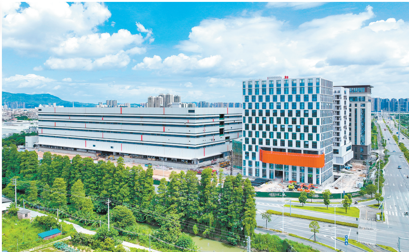
今年以来，礼乐街道立足“农业+工业”双擎驱动的发展定位，争当江海产业发展生力军。图为江金多多生产研发基地项目现场。
